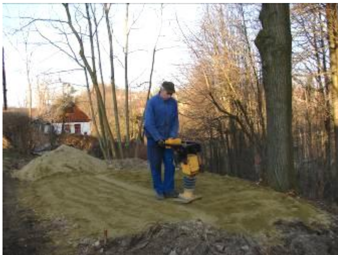
F. Jílek při zhutnění šterk. podkladu pod kontejnery.
