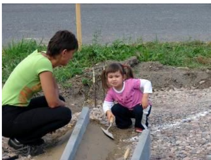
Při stavbě nám pomáhala i Kateřina Bartoňová.
