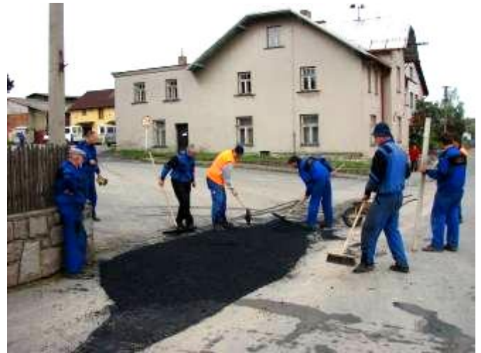
Oprava překopu u vjezdu do areálu družstva.
