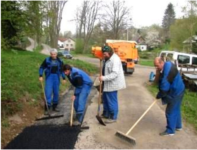
Zpevnění krajnice na komunikaci ke Košňarovým.
