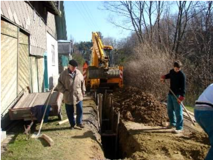
Oprava vodovodního řadu u dolního rybníka.
