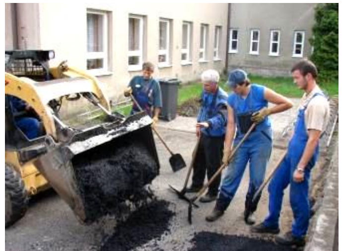
Oprava parkoviště u základní školy.
