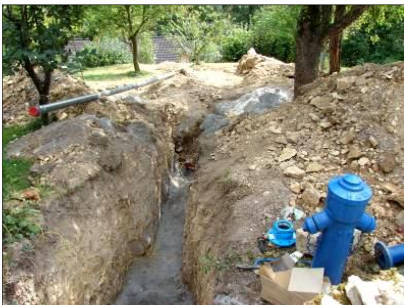
Výměna vodovodního řadu od pana T. Kubeše směrem k dolnímu rybníku.
