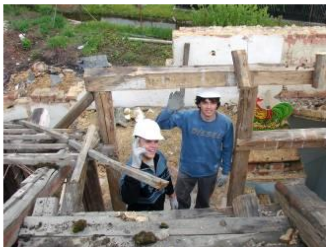
T. Chadima a P. Vomáčka – demontáž vazby
