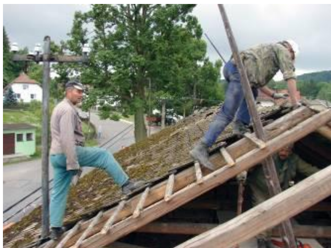
J. Mička a M. Kovář odkrývají střešní krytinu
