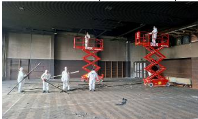
Sanace požárem zasažených částí tělocvičny
