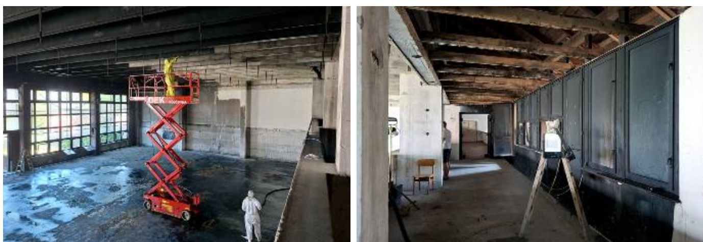
Dekontaminace panelů a galerie
