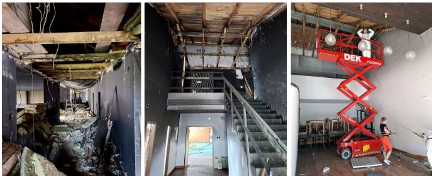
Odstranění stropních obkladů a tepelné izolace
