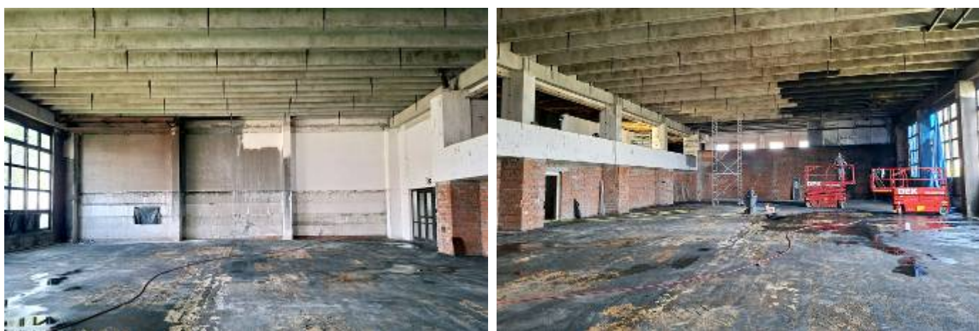
Pohled na vyčištěný prostor sálu Skalky
