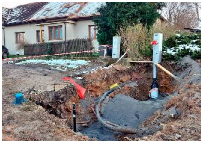
Výměna hydrantů u čp. 146 a Huntovny
