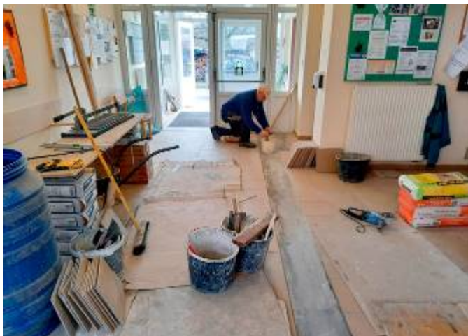
Výměna vodovodního potrubí v DPS
