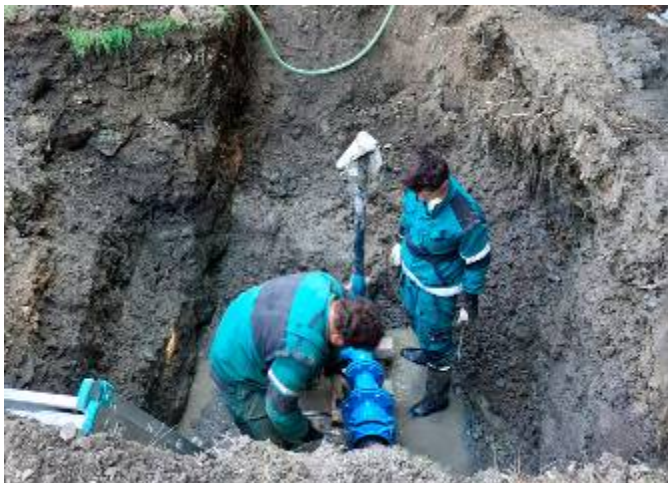
Výměna hydrantů u autobusových garáží
