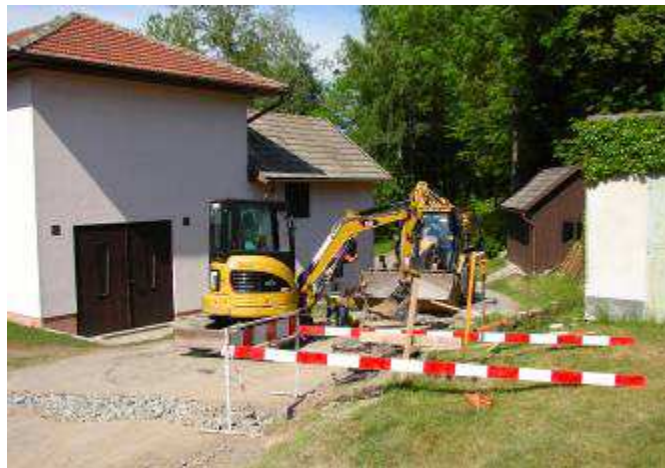
Příprava štěrkového podkladu a dešťové kanalizace
