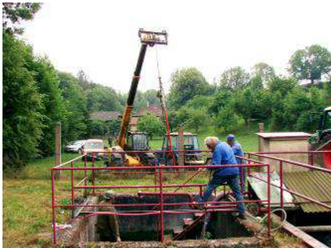
Oprava čerpadla na čističce odpadních vod
