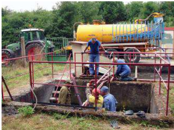
Oprava čerpadla na čističce odpadních vod
