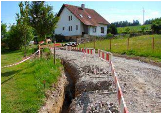
Příprava štěrkového podkladu a dešťové kanalizace
