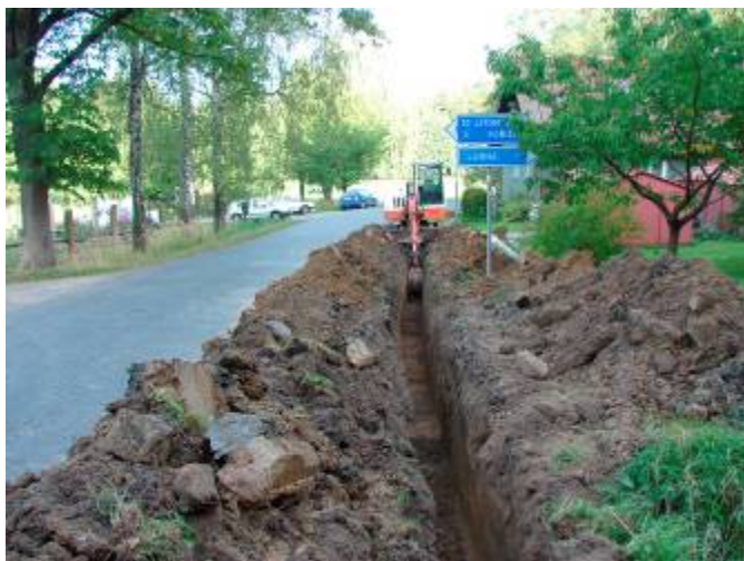
Kabelová přípojka NN k vodojemu
