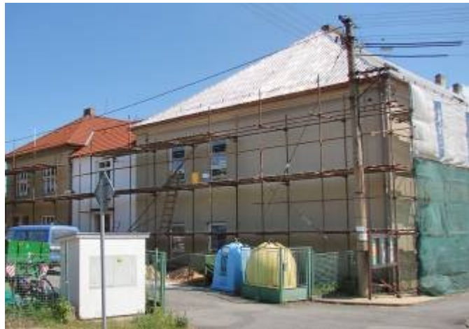
Postavené lešení na zateplení vnějšího pláště budovy
