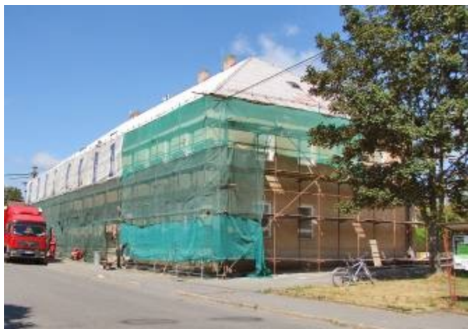
Postavené lešení na zateplení vnějšího pláště budovy
