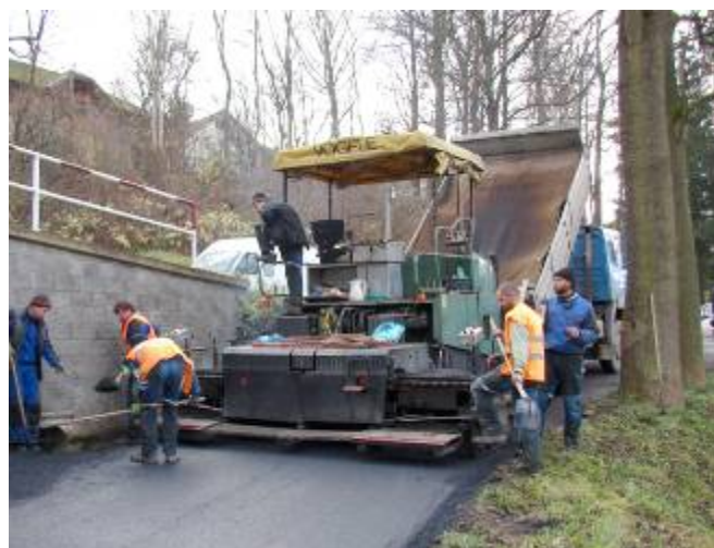
Štěrkové vyrovnání a pokládání živičného povrchu
