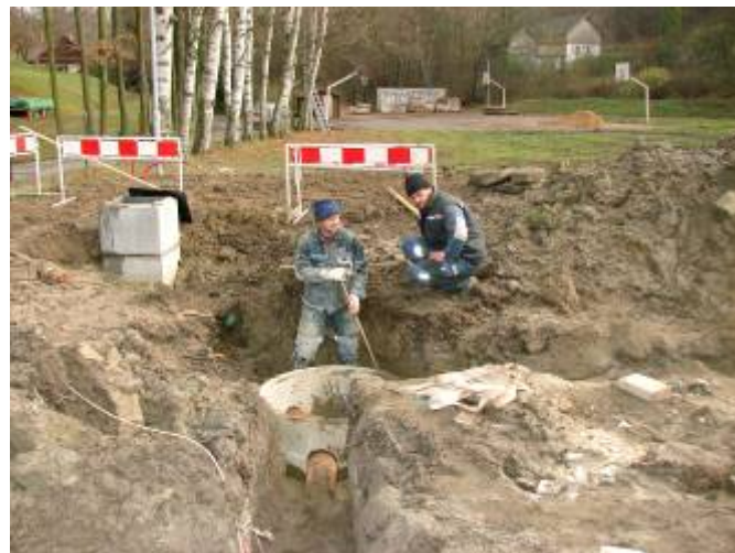
Pracovníci firmy DS DELTA při usazování kontrolních šachet
