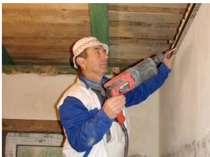
Montáž stropu na toaletách
