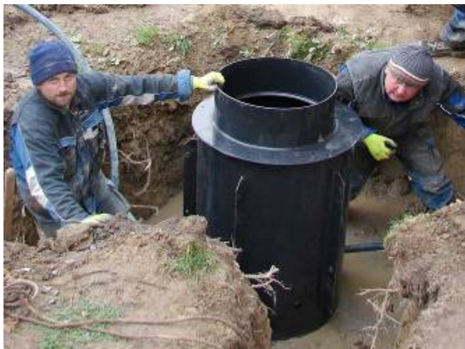
Pracovníci firmy DS DELTA při usazování kontrolních šachet
