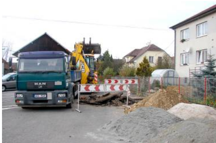
Oprava vodovodní přípojky do bytového domu
