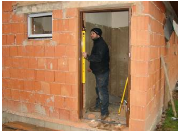
Usazování oken a dveří u sociálního zařízení
