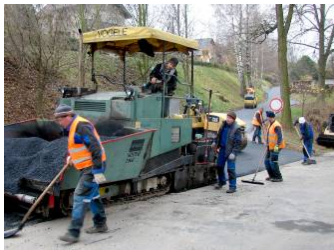
Štěrkové vyrovnaní komunikace a pokládání živičného povrchu
