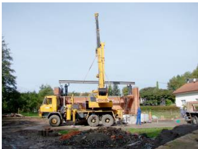
Pokládání nosníků u objektu pódia
