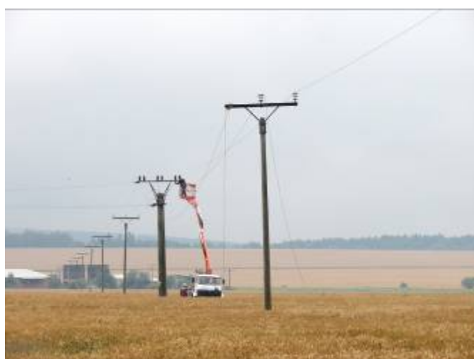
Oprava poškozeného el. vedení za družstvem
