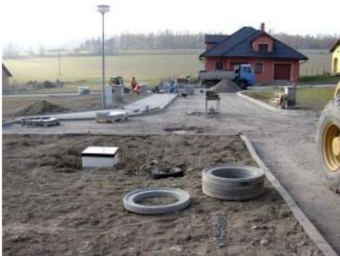
Položení zámkové dlažby do pojízdného chodníku
