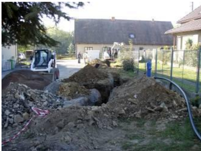
Oprava vodovodního řadu a přípojek podél školy a v zahradě u Kovářových
