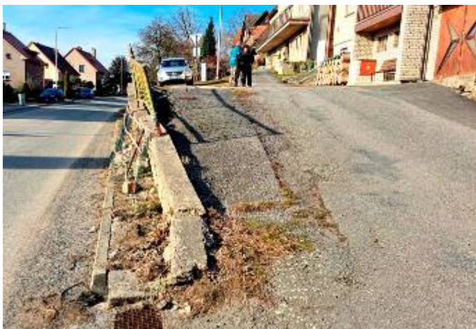
Současný stav poškozené zdi naproti prodejně COOP
