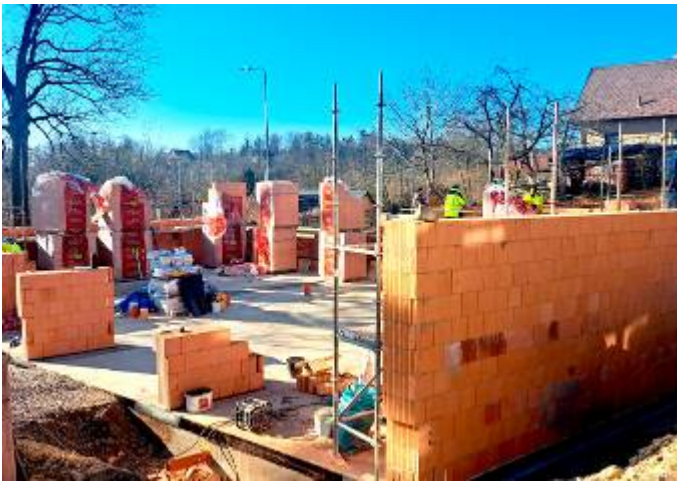
Stavba nosných konstrukcí objektu
