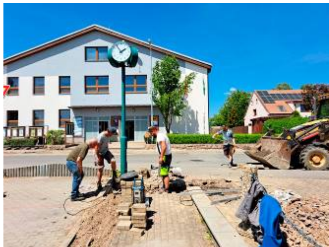
Instalace dobíjecího stojanu na elektrokola
