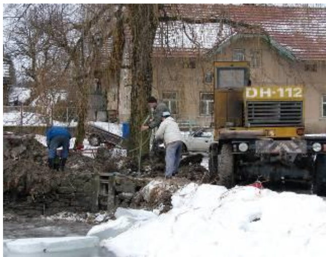
Odčerpávání vody z výkopu
