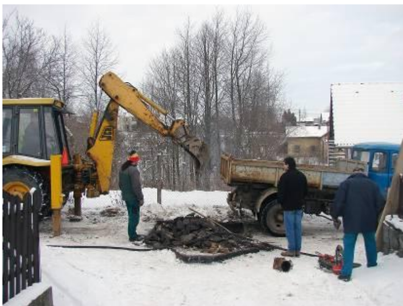
Oprava vodovodu na Malé Straně
