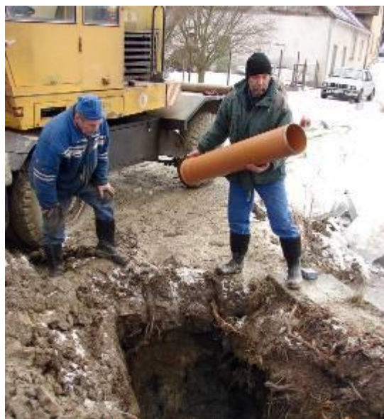
Usazení nového odtokového potrubí
